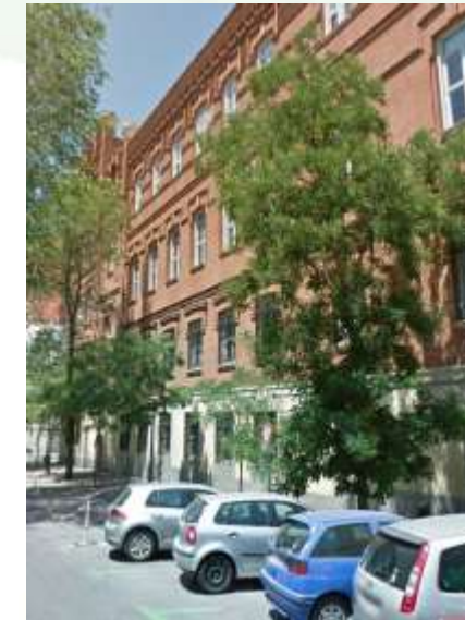
Calle Santa Cruz de Marcenado Mala adecuación Porte/Distancia
