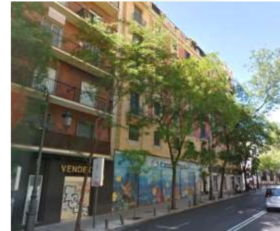
Calle de Bailén Mala homogeneidad
